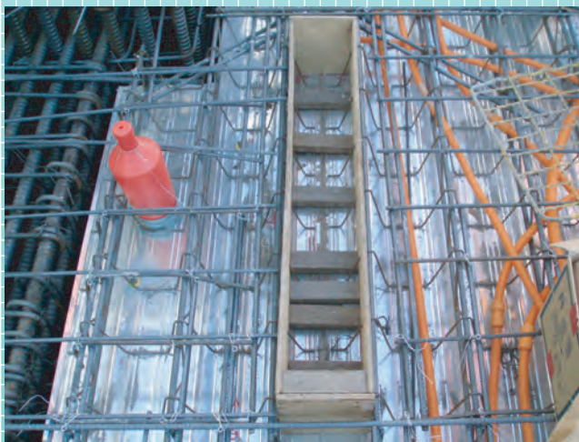
仮設ダメ穴開口
