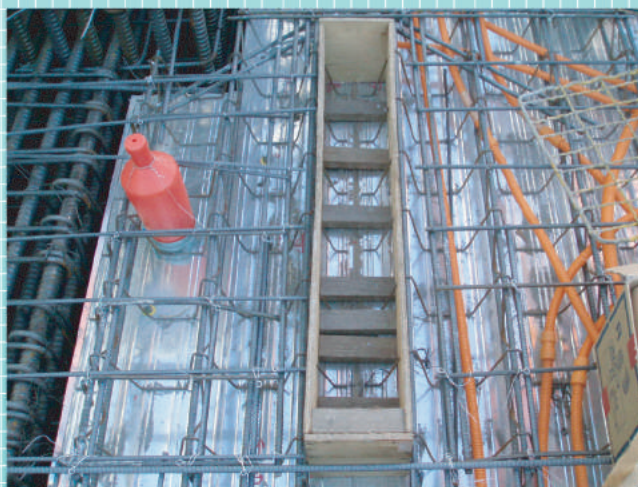
仮設ダメ穴開口
